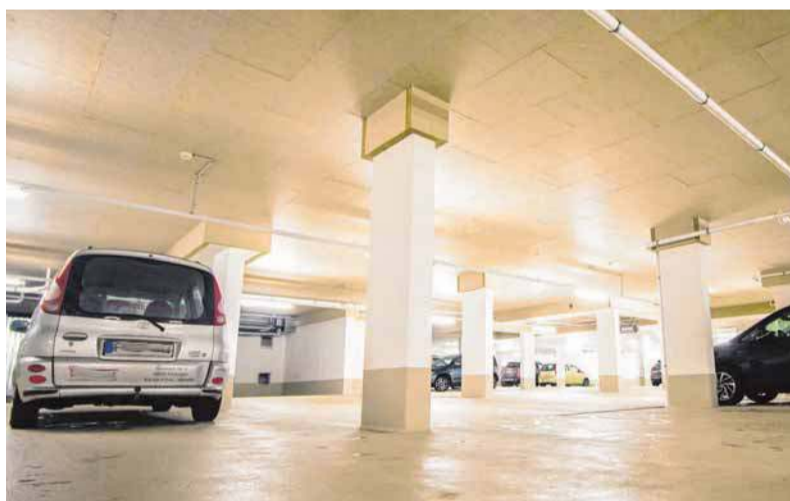
Noch viel Platz ist in der Tiefgarage unter dem Einkaufsmarkt.
